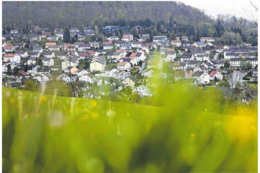
Die Buchhalde ist ein wenig in die Jahre gekommen. Das gilt für viele Häuser und deren Heizquellen, aber auch die Leitungen. Wenn in naher Zukunft erneuert wird, soll auch gleichzeitig eine energetische Sanierung auf den Weg gebracht werden.
